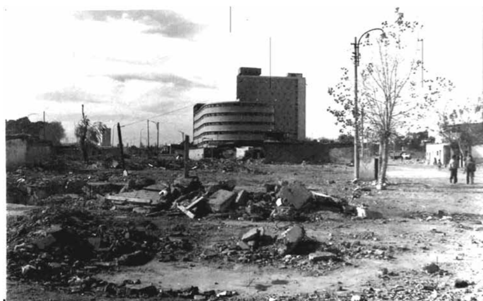
Foto 5. Demoliciones en el Barrio Comunicaciones.
